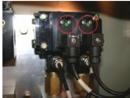
Abbildung Federspeicher-Impulsventil
